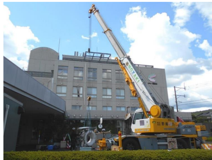
CT装置を搬入している様子。 クレーン車で吊り下げられています。
